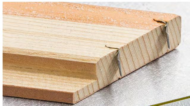
Abb. 2: Mit solchen eingepressten Metallhaken kann die Eckverbindung eines Holzrahmen weiter stabilisiert werden (alternativ zu eingeleimten Holzfedern).
