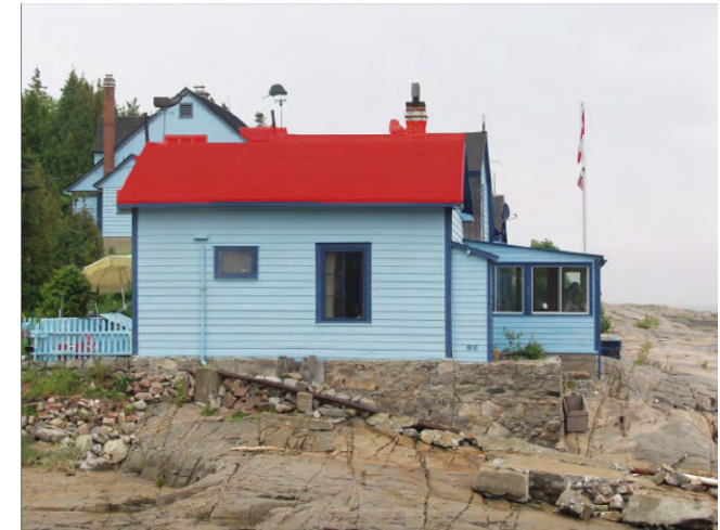
Abb. 2: Es wurden das dunkle Dach und Teile der Schornsteine ausgewählt. Die Anzeige ist hier im Q-Modus mit der Einstellung ›Ausgewählte Bereiche‹ zu sehen.
